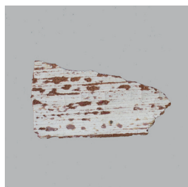
Rückseite der Abblätterungen mit weissem Altanstrich.
