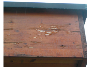
Acryllasur auf Holz mit Rissen (C) Beginnende Abblätterungen entlang den Rissbildungen im Holz.
