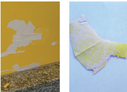
Ablösungen eines Dispersionsanstrichs auf einem «mehligen» Weissputz (ohne Polymerzusatz).
