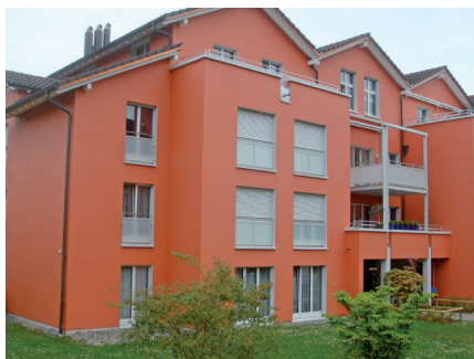
Rot-Oranger Fassadenanstrich mit RUCOCOLOR
