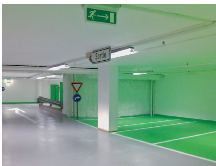
Bodenanstrich in einer Tiefgarage
