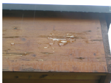
Dickschichtlasur auf Acrylbasis Beginnende Ablätterungen entlang den Rissbildungen im Holz.
