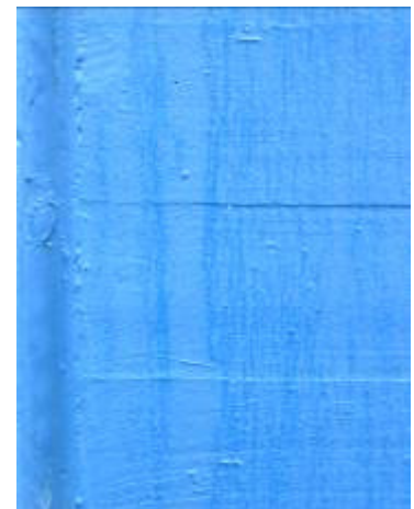
Streifenbildungen auf einem blauen Dispersionsanstrich infolge von Tauwasser-Ablaufspuren!
