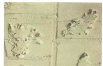
Abdrücken eines Dispersionsanstrichs (ohne Tiefengrund) auf KS-Mauerwerk
