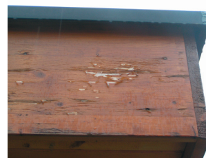
Glacis acrylique sur bois fendillé (C) Début d'écaillage le long des fendillements dans le bois.
