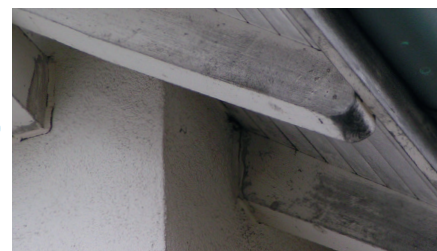
Attaque fongique sur un revêtement à l'huile
