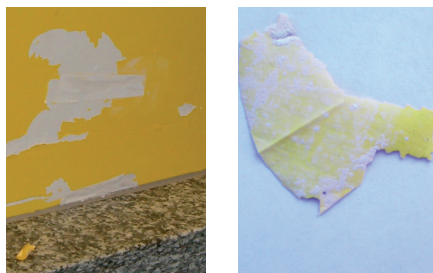
Décollement d'une peinture de dispersion sur un crépi blanc «farineux» (sans additif de polymère).
