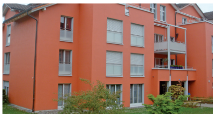
Revêtement de façade avec RUCOCOLOR
