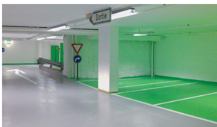
Revêtement de sol dans un parking souterrain
