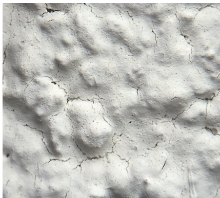
L'ajout de 2 % de fibres acryliques permet de boucher les microfissures fines dans le crépi.
