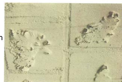
Traces sur une couche de dispersion (sans fond pénétrant) réalisé sur une maçonnerie en grès calcaire)
