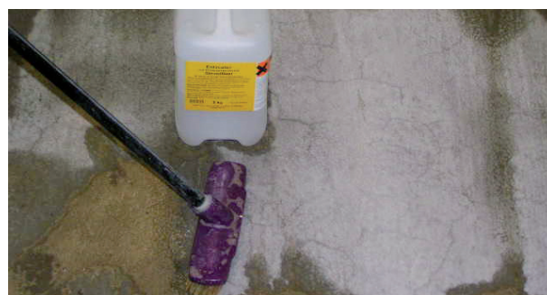
Élimination de la laitance avec le dérouilleur RUCO
