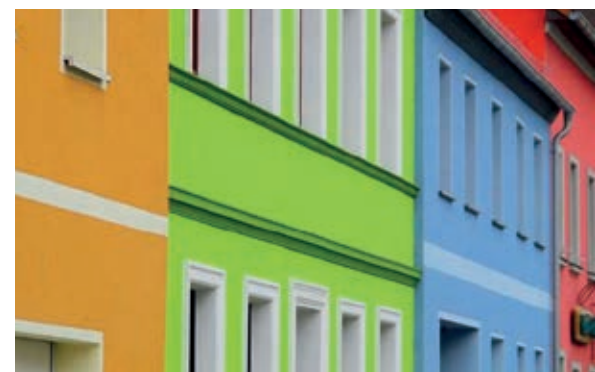
Des peintures de dispersion avec des pigments organiques sont nécessaires pour les teintes vives.
